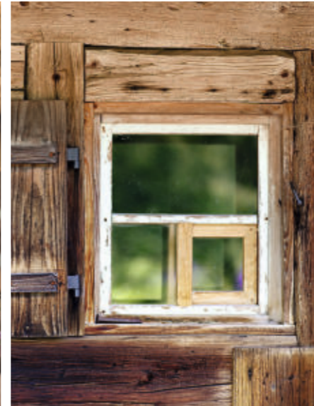
Hier ist ein Teil eines Stubenfensters eingebaut, ergänzt um einen Schieber.
