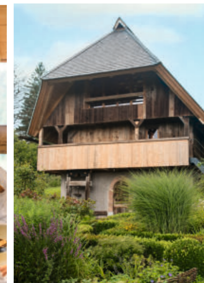
Der zum Hof versetzte Speicher sitzt auf einem Sockel aus Recyclingbeton.
