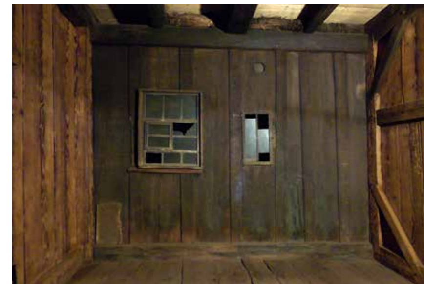
Abb. 11: Schlafkammer im Stammelhof von 1789. Die Zwischenräume zwischen Decke und Wand wurden mit Stroh ausgestopft.
