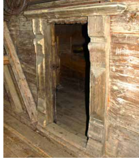
Abb. 34: Der Eingang in den Kornkasten des Metzgerhofspeichers in Wolfach-Ippichen mit einem Portal nach einer Musterzeichnung aus der Renaissance (18. Jh.). Aufnahme 2015
