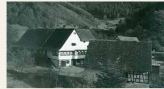
Abb. 69: Zustand 1936. Sichtbar ist im Vergleich zu Abb. 67 die leichte Dachaufklappung an der Längsfassade, um mehr Licht in die Räume zu lenken.
