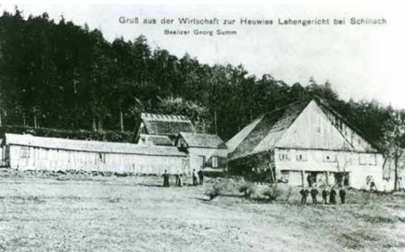
Abb. 46: Das Gütle und Gasthaus Heuwies um 1915. Die Frontfassade wurde bis auf die Vorderkante des früheren Trippels vorgezogen und abgestützt. Anbau unter großer Dachaufklappung.
