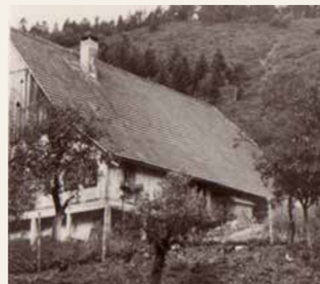
Abb. 72: Der untere Teil im Zustand von 1922, das Fachwerk etwas besser sichtbar.
