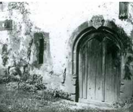
Abb. 32: Der aufwändige Portaleingang in den Keller des Kornspeichers auf Höfen (1604). Rechts an der Hausecke die Hofzeichen. Aufnahme 1935
