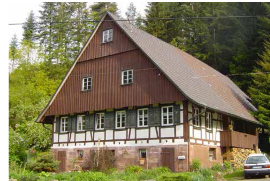
Abb. 5: Der Konradshof Vor Erdlinsbach. Fachwerk von um 1850. Aufnahme 2006
