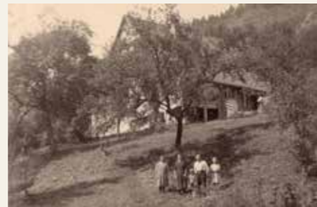
Abb. 71: Der Hof im Oberreichenbächle nach 1934. Der obere Teil wurde durch eine Widerkehr erweitert, der untere Teil zeigt noch den Zustand von nach 1922 mit vorgezogenen Stuben und seitlicher Dachabschleppung.
