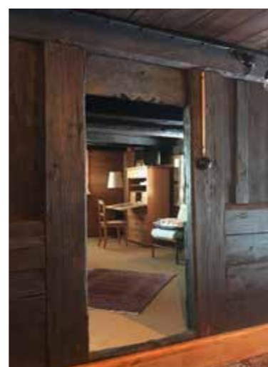
Abb. 28: Eselsrücken an der Tür in eine Gesindekammer beim Hinteren Liefersberger Hof auf dem Moosenmättle. Aufnahme 2016
